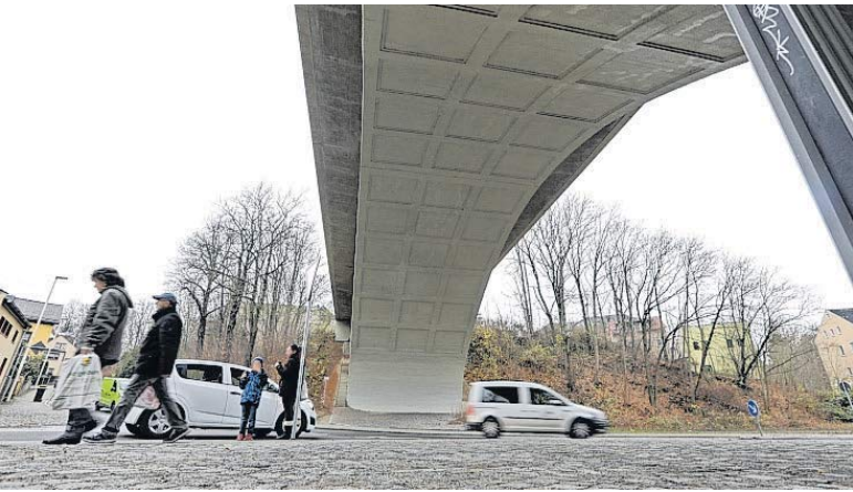
In der 2010er-Jahren ist die Glauchauer Scherbergbrücke in mehreren Bauabschnitten saniert worden.
